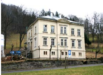
Abb. 7: FAKTOR 10 Sanierung' Pobershau Planung: Dipl.-Ing. Dawid Weisse Villa in Pobershau- Sanierung 2008
