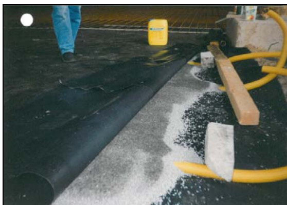
Abb. 5: Aufbau Drainageschicht Bauteil 7
