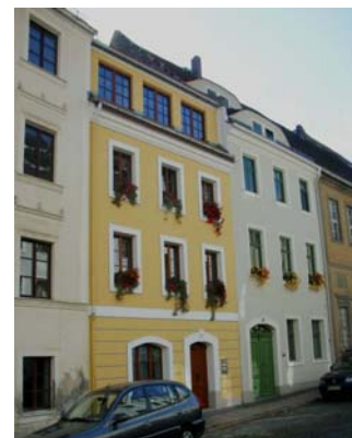
Abb. 12: Denkmalsanierung Conrad in Görlitz Pilotprojekt der DBU in Zusammenarbeit mit der TU Dresden- Bauklimatik Sanierung fast bis zum Passivhaus 2006
