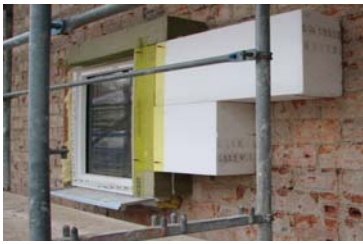
Abb. 4: 'FAKTOR 10-Sanierung' Freital 2006 GWG Freital 13 WE mit Lüftung u. WRG
