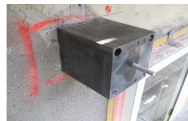
Abb. 3: wärmebrückenfreies Schwerlastelement zur Befestigung von Balkonen/Vordächern
