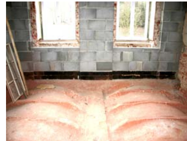
Abb. 9: Bimsbetonwände entkoppelt auf Schaumglas auf alten Kappengewölben
