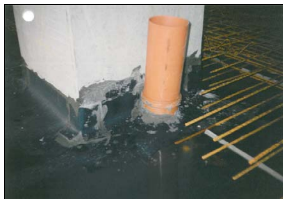
Abb. 6: Anbindung Radonschlot
