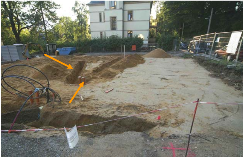
Abb. 1: ungleichmäßig tragfähiger Untergrund durch die nachträgliche Aufschachtung für die Medienrohre
