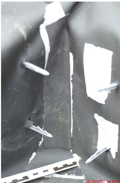
Abb. 4: Reststreifenverklebung
