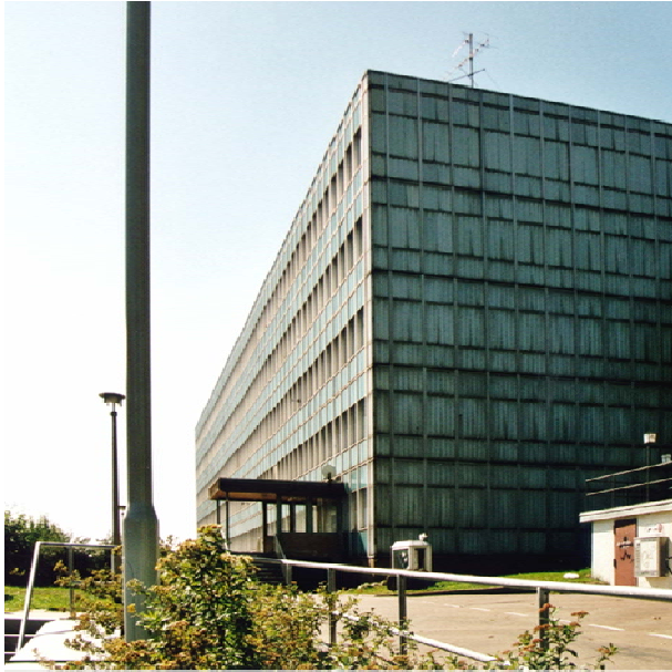
Abb.1: Nordansicht des Wohnheimes (1999)
