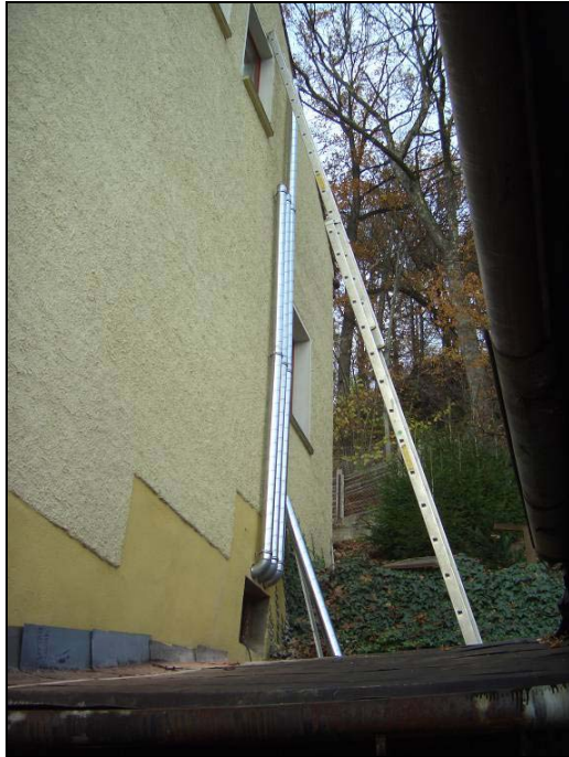
Abb. 12: Giebelwand mit Kaminrohren
