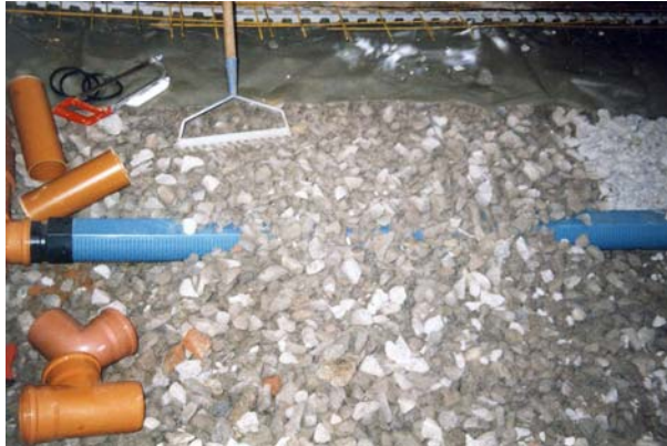
Abb. 3: Drainageröhre in der Schotterschüttung [2]
