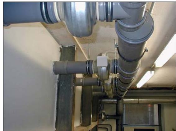
Abb. 9: Verbundene Drainagerohrleitungen mit eingebauten Rohrlüftern
