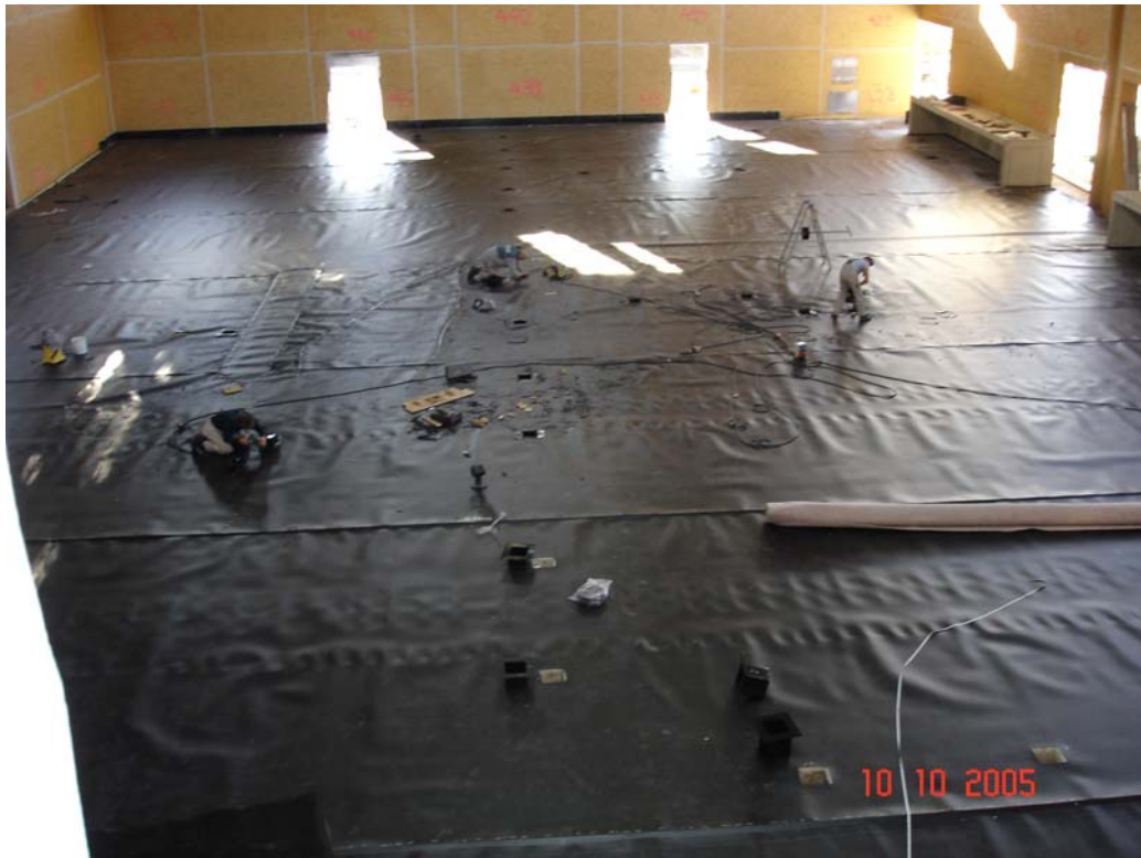
Abb. 5: Horizontale Abdichtung
