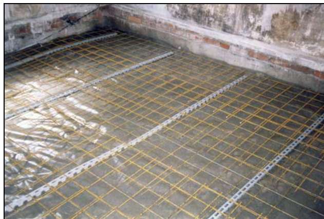
Abb. 4: Radondichte Folie mit aufgebrachtter Armierung
